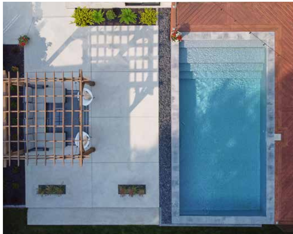
Vue aérienne de la Trévi Futura, avec un seul niveau de profondeur. Escalier pleine largeur avec plateau et recouvrement de toile. Aerial view of Trevi Futura pool with single depth level. Liner-covered full-width steps with landing.
